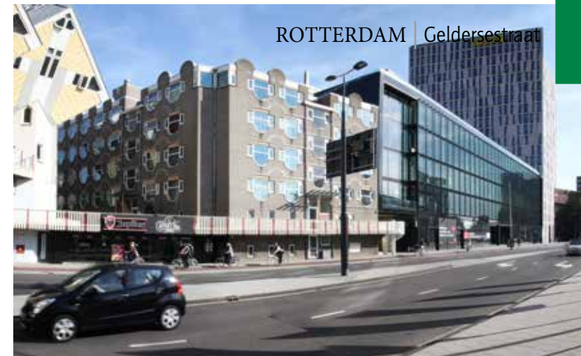
De Geldersestraat vóór de gevelrenovatie
