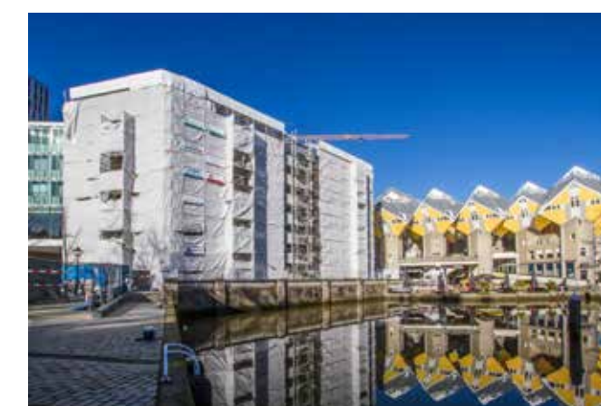
Geldersestraat tijdens de gevelrenovatie
